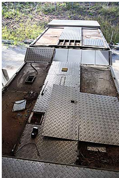
Le reste du toit : les panneaux solaires ont été enlevés. La partie centrale est un passage que je laisse en place pour le moment.
