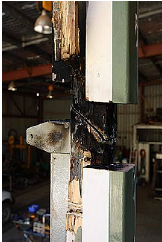
L'un des piliers arrière avec le bois enlevé et la découpe au chalumeau.
