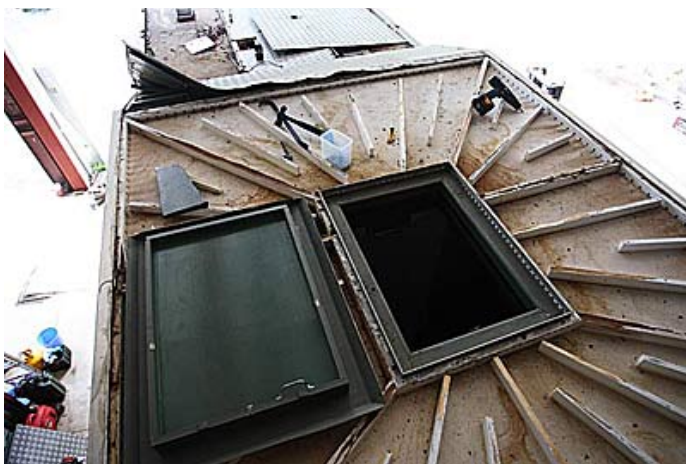
Le toit ouvrant sans la partie extérieure en tôle striée.
